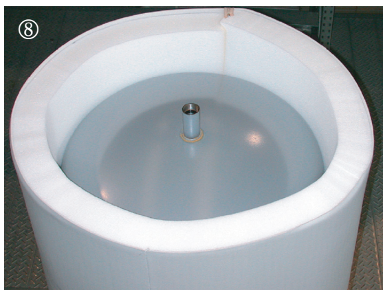
Obrázky znázorňující postup montáže izolace z měkké pěny s PVC fólií na nádrž.
