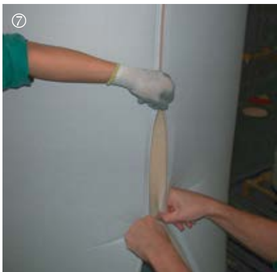
Obrázky znázorňujúce postup montáže izolácie z mäkkej peny s PVC fóliou na nádrž.
