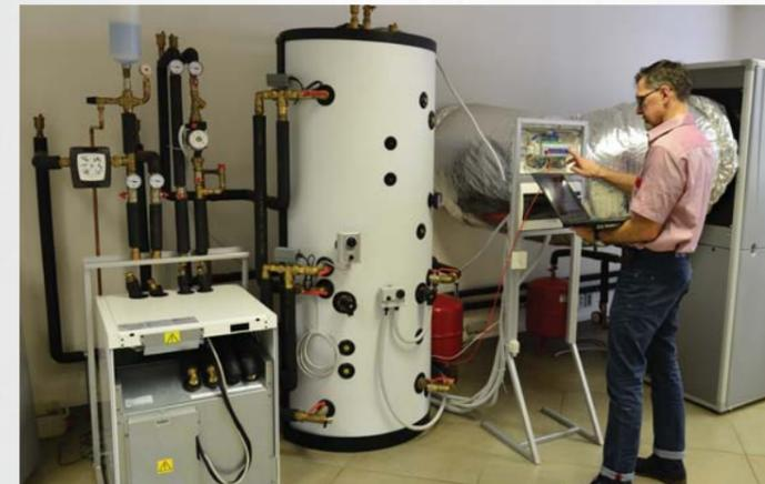
Druckprüfung von Pufferspeichern
