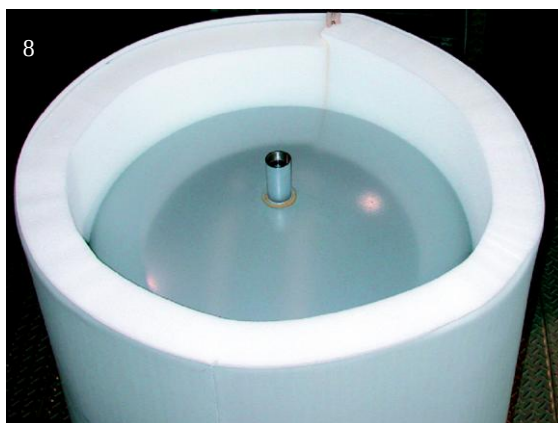
Obrázky znázorňujú postup montáže izolácie z mäkkej peny s PVC fóliou na nádrž.
