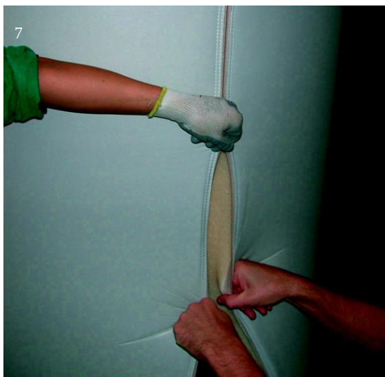
Obrázky znázorňujú postup montáže izolácie z mäkkej peny s PVC fóliou na nádrž.
