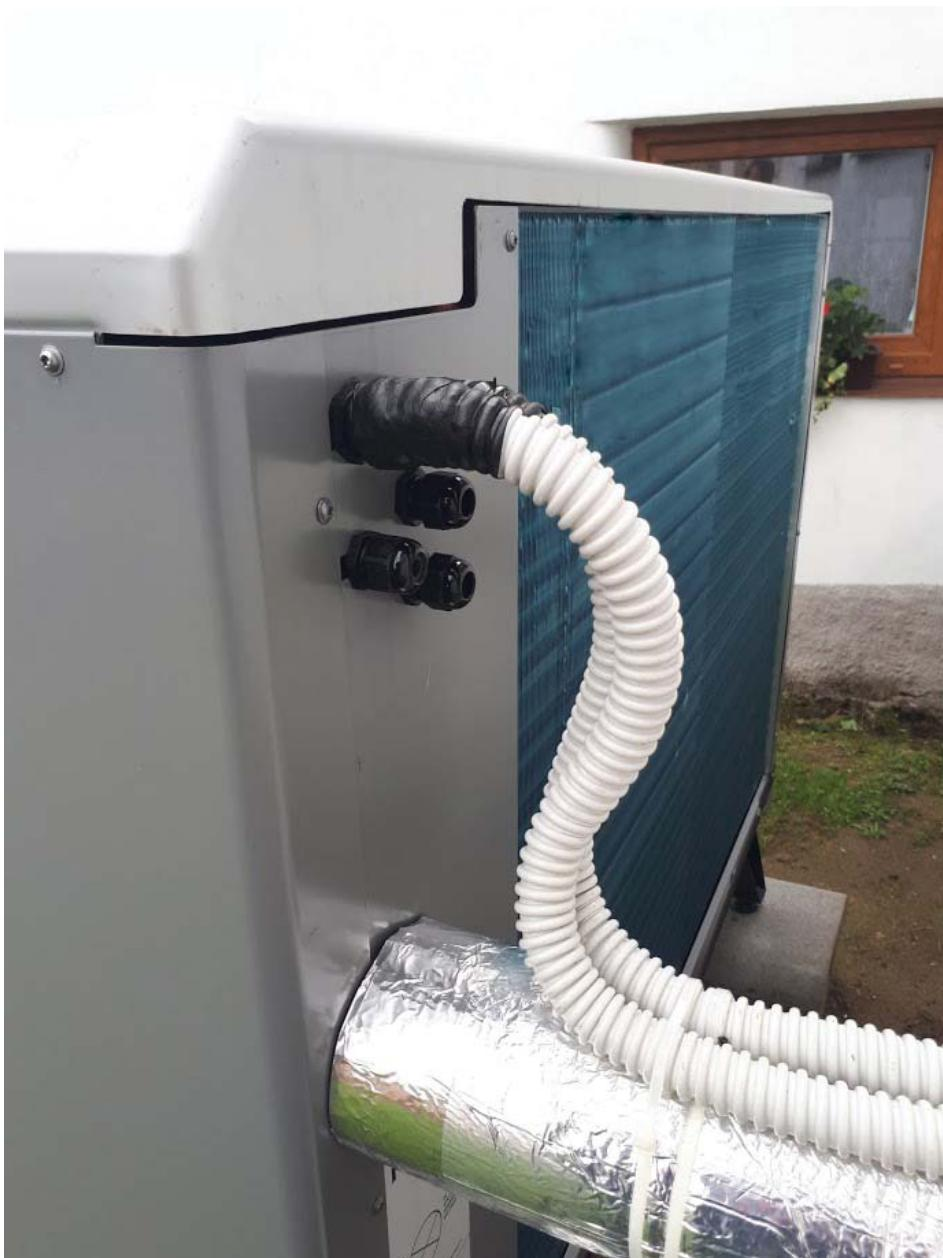
Odporučame preto v blízkosti tepelného čerpadla inštalovať elektroinštalačnej krabici alebo vypínač (v niektorých krajinách EÚ povinný), a tam napájací kábel napojiť.
