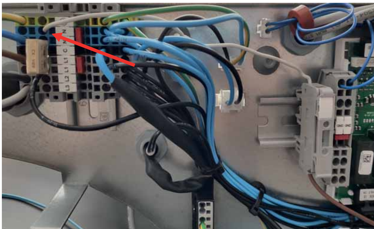
Obr. 1b– Pripojenie vykurovacieho kábla na svorkovnici - tepelné čerpadlo CTC série 600
