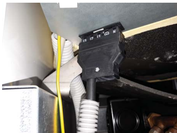
Pripojenie do konektora X10 - pohľad zdola.
