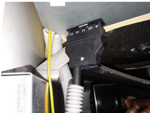
Pripojenie do konektora X10 - pohľad zdola.
