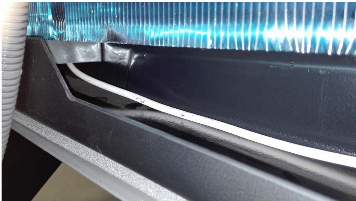
Obr. 2 - Pretiahnutie ohrevného kábla zberačom kondenzátu
