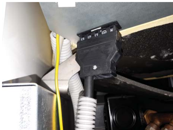
Pripojenie do konektora X10 - pohľad zdola.
